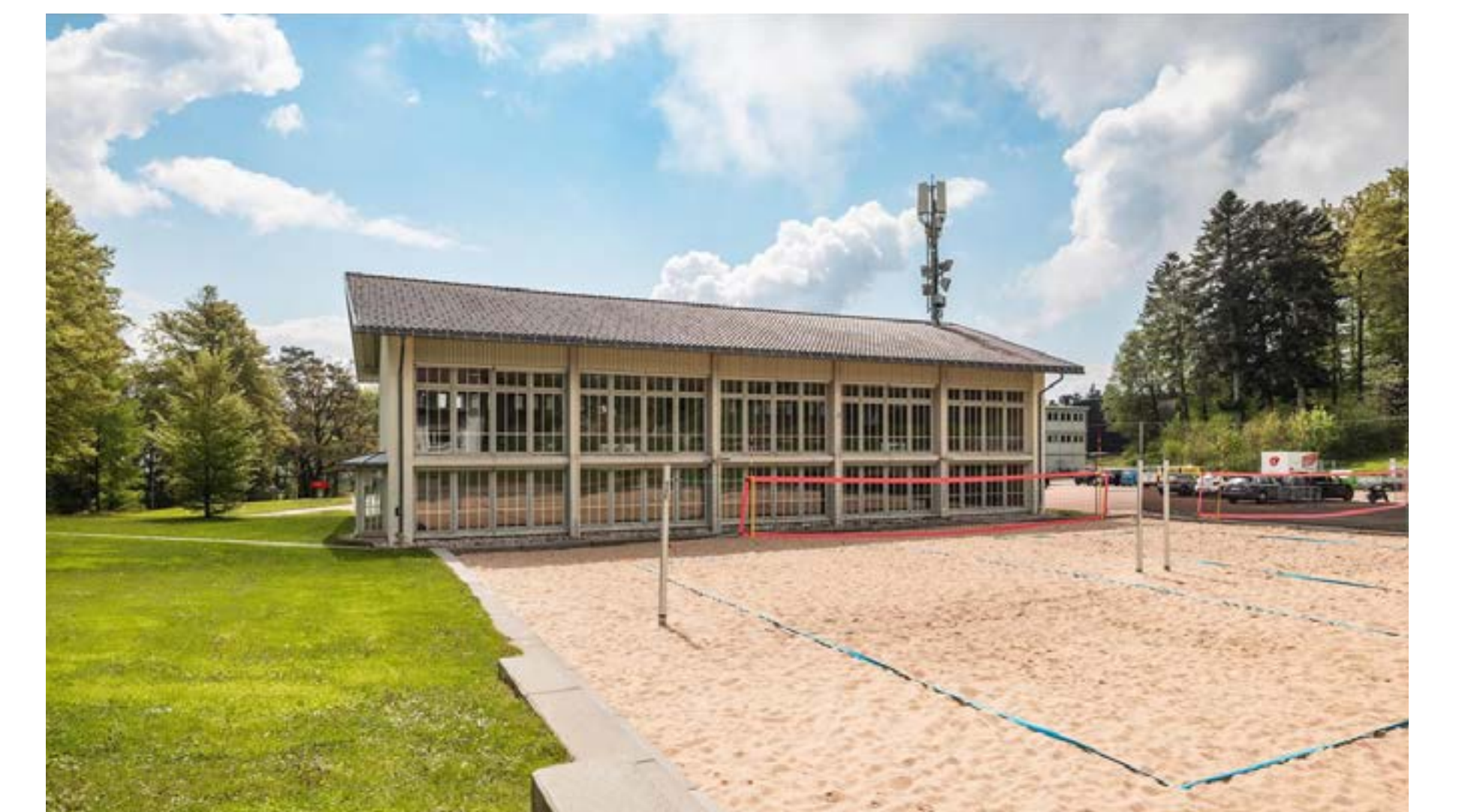
Exemple de l'approvisionnement en chaleur : l'ancienne salle de sport, qui a plus de 80 ans, sera également raccordée au nouveau réseau de chaleur à distance à l'avenir et alimentée en énergie thermique durable. (© OFSPPO)
