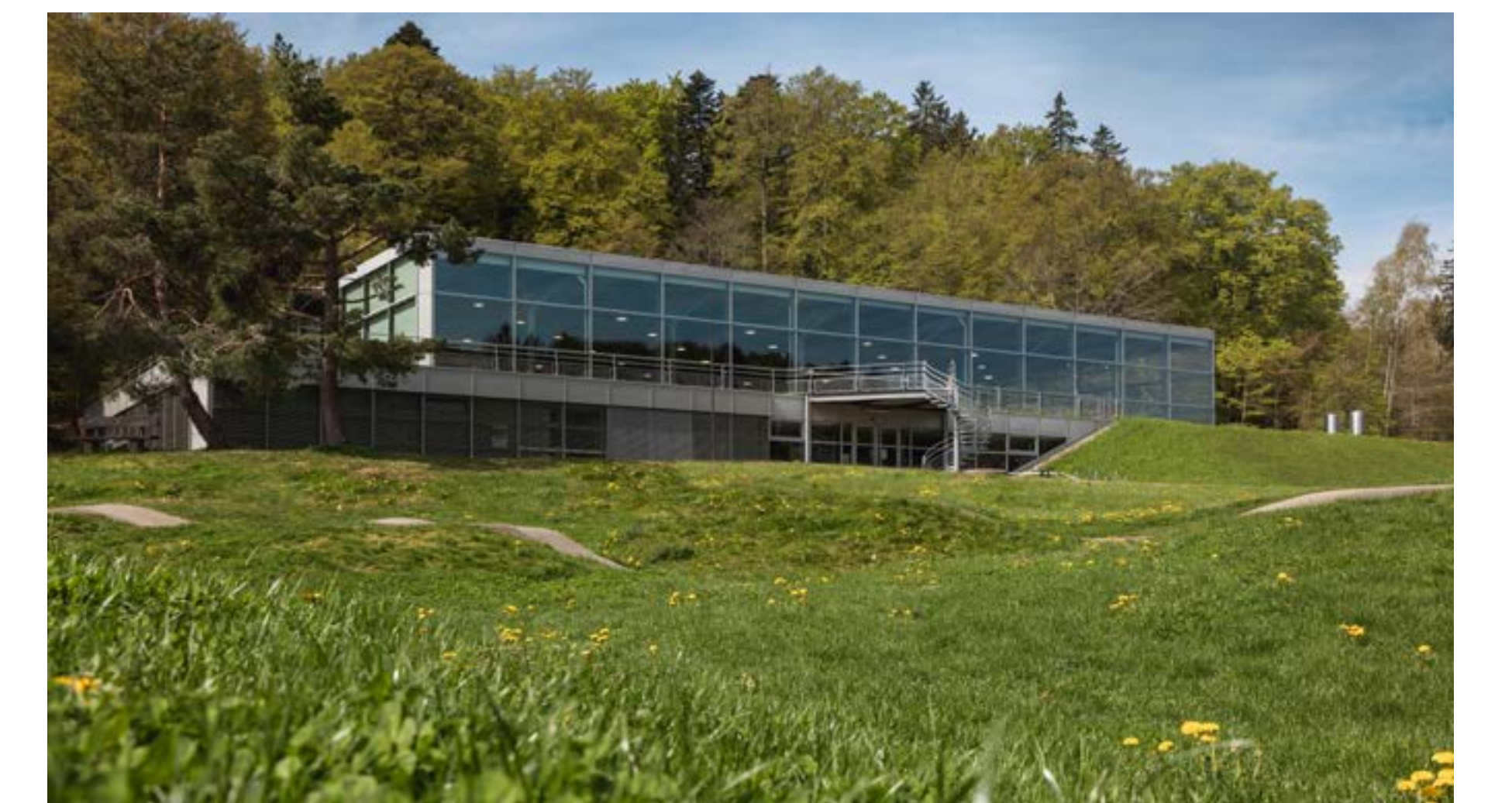
Exemple de l'efficacité énergétique : dans le cadre de l'assainissement prévu de la salle du Jubilé, à l'avenir, les besoins en chaleur peuvent être réduits de 50 % et les besoins en électricité de 20 %. (© OFSPPO)
