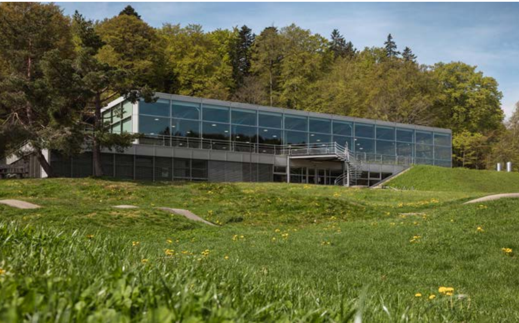
Construite en 1982, la salle du Jubilé n'est pas l'un des plus anciens bâtiments de l'OFSPPO. Après des décennies d'utilisation intensive, un assainissement de la salle de gymnastique artistique est toutefois nécessaire. Cela garantit l'exploitation pour les générations futures. (© OFSPPO)
