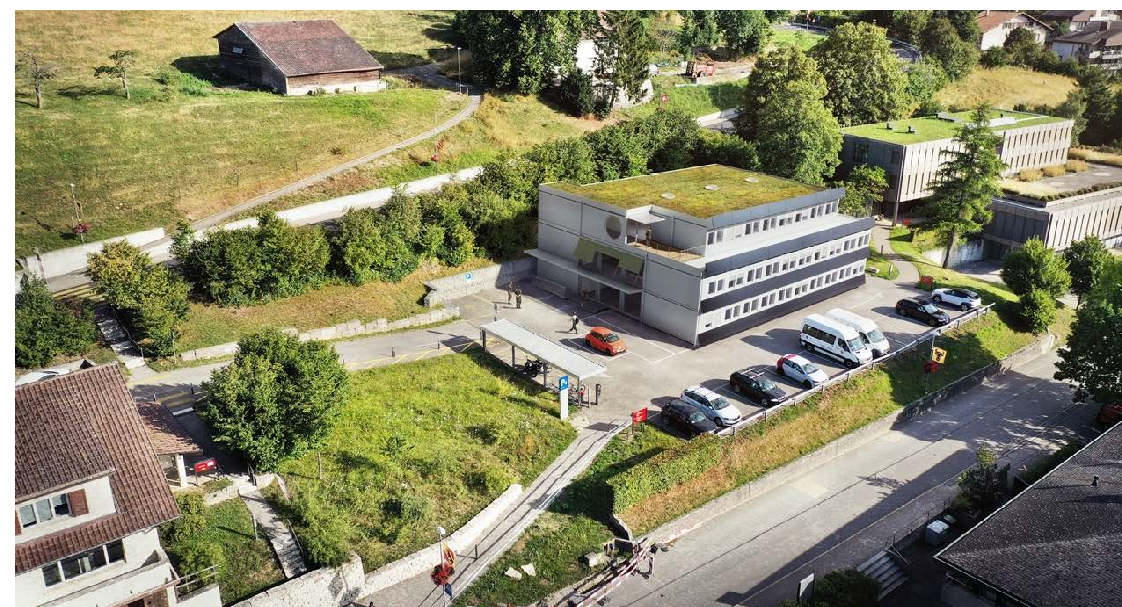
Le bâtiment provisoire de deux niveaux avec attique sera construit sur le parking P4 à proximité immédiate de la Maison du Jura. (© 115West°/VINN)
